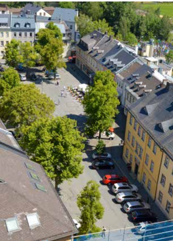
Blick auf den Maxplatz: Mitten in Hof! Das Bild stammt von einer Turmbe- steigung im Jahr 2015 während der Sanierung der Fassade der Michaelis- kirche. Foto: Claudia Schott
